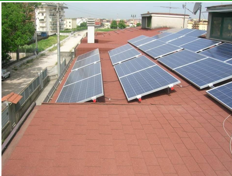
Figura 9 - Esempio di installazione non idonea alla classificazione dell'impianto fotovoltaico nella categoria "su edifici" – Motivazione: i moduli non sono complanari alla falda di copertura
